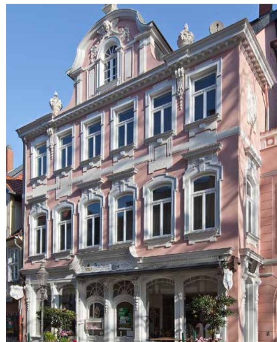
Restaurierte Fassade „Am Magnitor“
