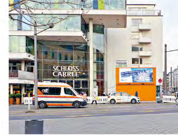
Die äußerlich sichtbaren Umbauarbeiten am Schlosscarree sind in vollem Gange
